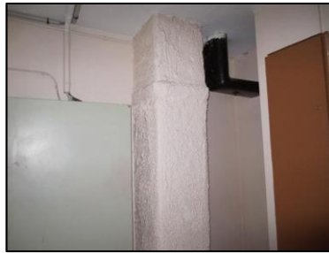
Photo N° 925 AMIANTE CIMENT -- DEGAGEMENT -1 Gaines & coffres verticaux Ventilation haute (Fibres-ciment)
